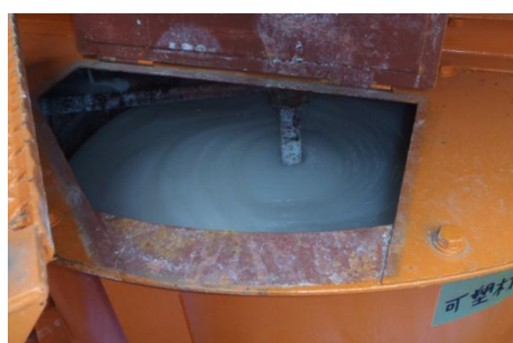
(b)可塑性材練混ぜ状況
