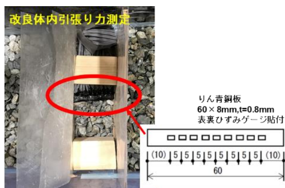
参考写真-6.2 りん青銅板の設置状況
