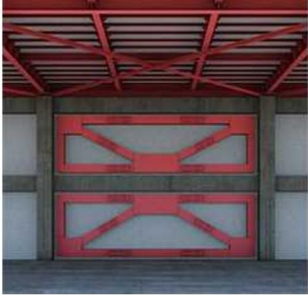
②コンクリート充填鋼管（CFT）造
