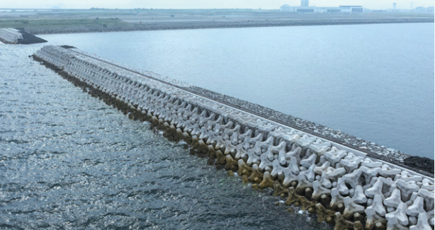
浚渫土砂の受け入れ先として整備された南護岸
