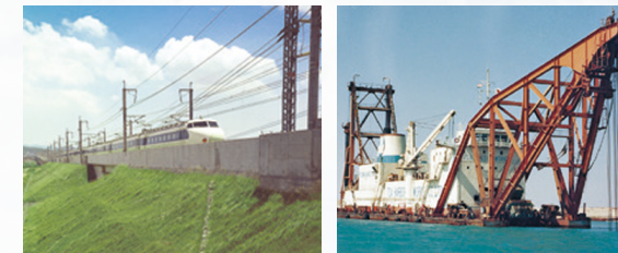
山陽新幹線西厚狭地区工事
