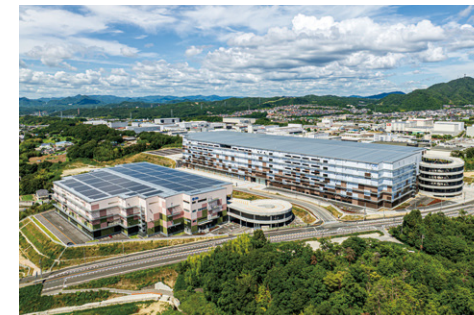
(仮称)CPD西宮北物流施設I新築工事(兵庫県) 発注者 神戸ロジスティクス特定目的会社
