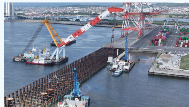
土留（ケーソン）据付け状況
