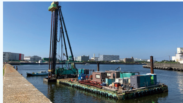
高圧噴射攪拌工法による海上地盤改良状況
