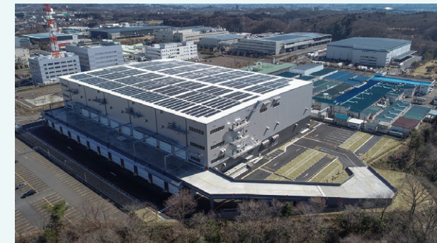
『ZEB』施設の仙台泉物流センター
