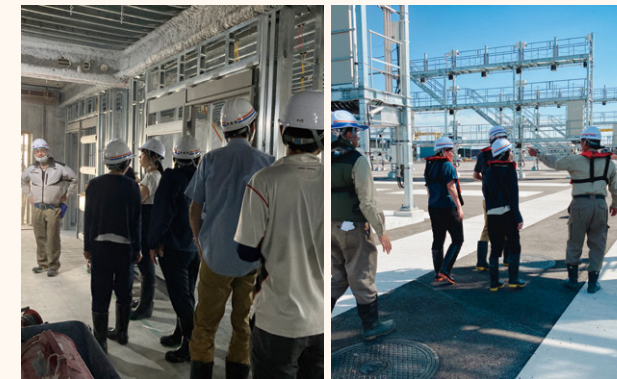
工事現場の見学の様子
