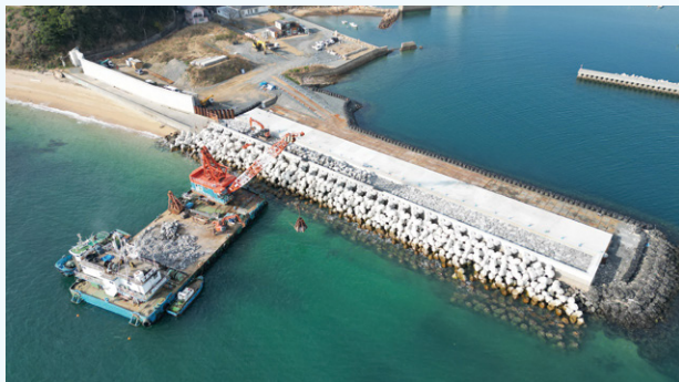
護岸改良工事の状況
