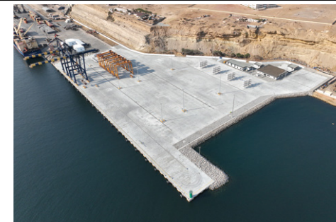
ナミベ港コンテナターミナル拡張事業(アンゴラ共和国) 発注者 アンゴラ共和国 運輸省
