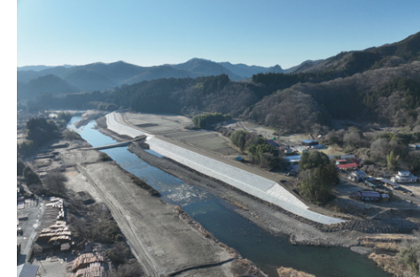
R5久慈川右岸頃藤北地区整備工事(茨城県) 発注者 国土交通省 関東地方整備局
