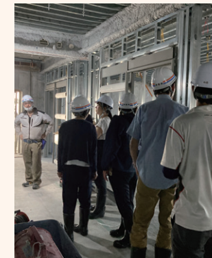
工事現場の見学の様子
