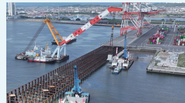
土留（ケーソン）据付け状況
