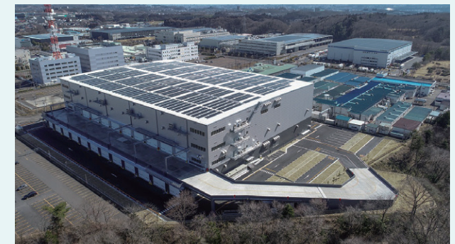
『ZEB』施設の仙台泉物流センター
