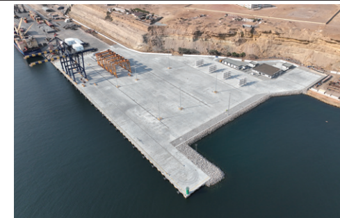
ナミベ港コンテナターミナル拡張事業(アンゴラ共和国) 発注者 アンゴラ共和国 運輸省
