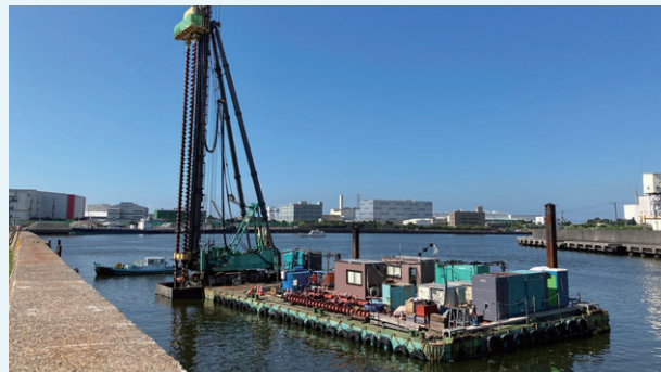
高圧噴射攪拌工法による海上地盤改良状況
