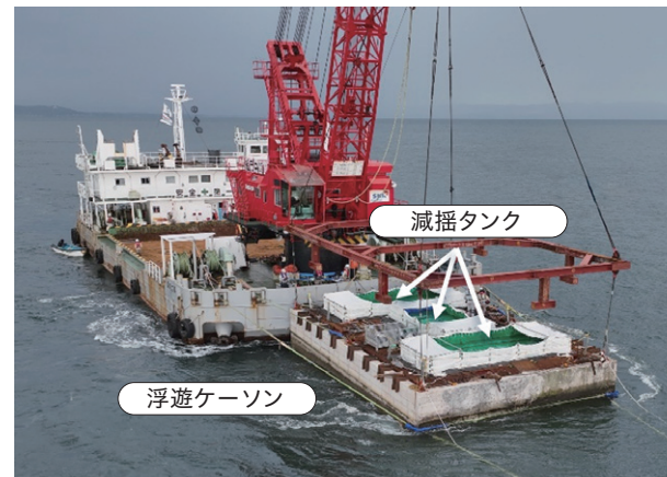
伏木富山港富山地区岸壁工事での本技術導入状況
