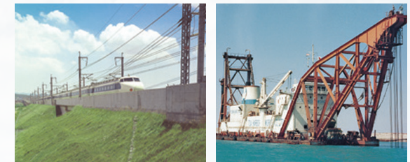
山陽新幹線西厚狭地区工事
