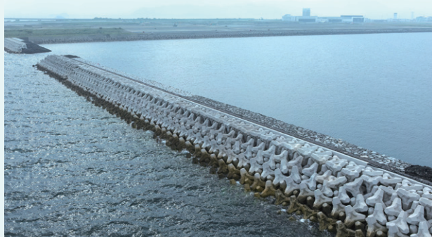
浚渫土砂の受け入れ先として整備された南護岸
