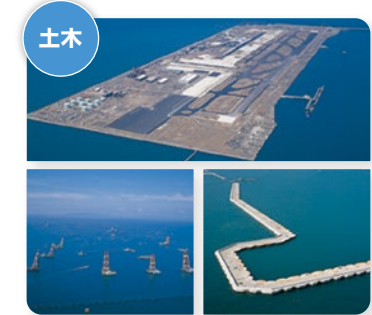
▲関西国際空港第1期工事
