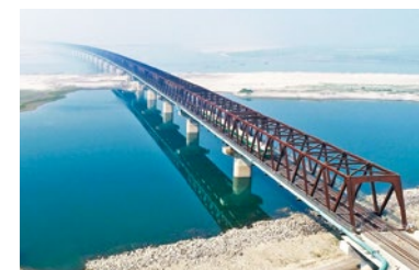
▶ジャムナ 鉄道橋建設工事 東工区 パッケージWD1* 発注者 バングラデシュ人民共和国鉄道省 ※ 従前より工事名が変更されました。 旧工事名:バングラバンドゥシェイクムジブ鉄道橋 建設工事 東工区 パッケージ WD1
