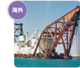
▲スエズ運河浚渫工事 (エジプト)
