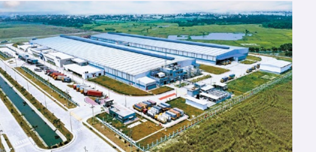
当社施工のシンガーバングラデシュ社・環境配慮型生産施設
