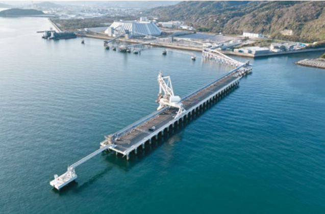
徳山下松港下松地区栈橋 (-19m) 完成
