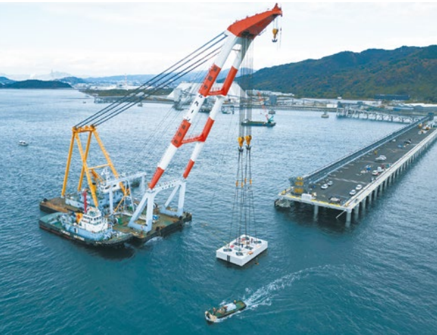
プレキャスト上部工据付状況
