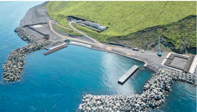
避難拠点港として整備を進める大島漁港
