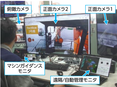
遠隔操縦／自動運転システムによる施工状況
