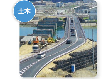
▲気仙大橋仮橋工事
