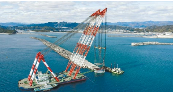
高知港の防波堤築造工事
