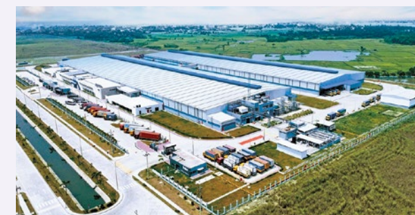
当社施工のシンガーバングラデシュ社・環境配慮型生産施設
