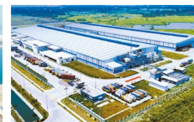
▶シンガーバングラデシュ 家電工場建設工事(Package-2) 発注者 Singer Bangladesh Limited
