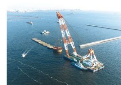
▶令和5年度 横浜港新本牧地区岸壁(-18m)(耐震)築造工事(その2) 発注者 国土交通省関東地方整備局
