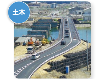
▲気仙大橋仮橋工事
