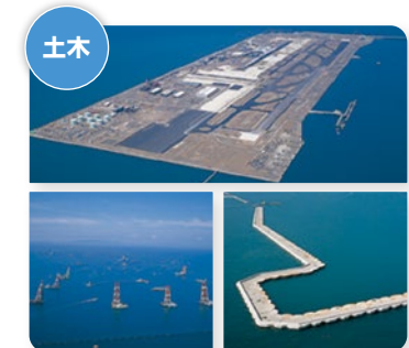
▲関西国際空港第1期工事
