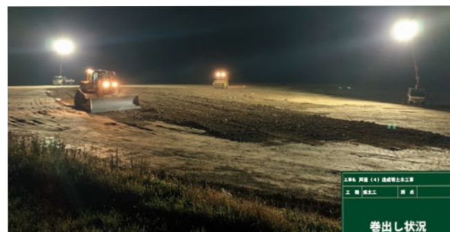
ICT施工による土砂敷き均し状況
