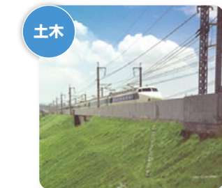
▲山陽新幹線西厚狭地区工事
