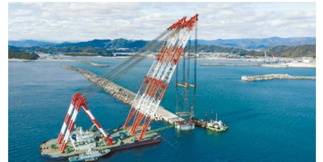
高知港の防波堤築造工事
