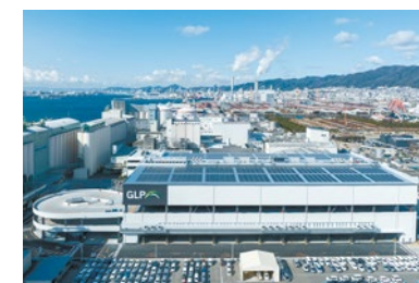
▶(仮称)GLP神戸住吉浜プロジェクト 発注者 GLP神戸住吉浜特定目的会社
