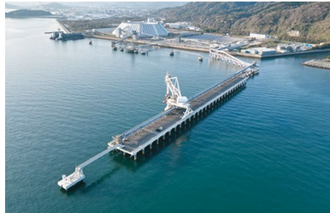
徳山下松港下松地区栈橋(-19m)完成
