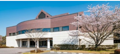
大学校舎改修事例
