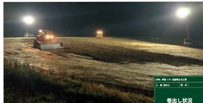
ICT施工による土砂敷き均し状況
