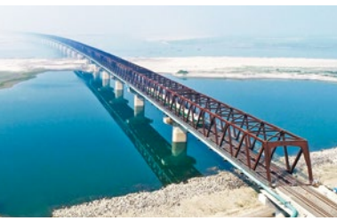
▶ジャムナ 鉄道橋建設工事 東工区 パッケージWD1* 発注者 バングラデシュ人民共和国鉄道省 ※ 従前より工事名が変更されました。 旧工事名:バングバンドゥシェイクムジブ鉄道橋建設工事 東工区 パッケージ WD1
