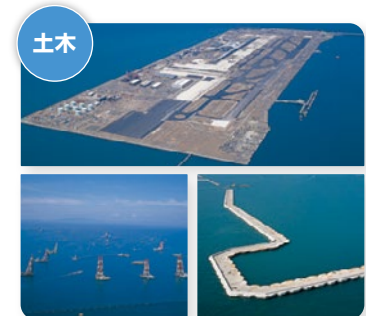
▲関西国際空港第1期工事
