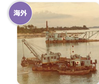
▲ジュロン地区浚渫工事 (シンガポール)
