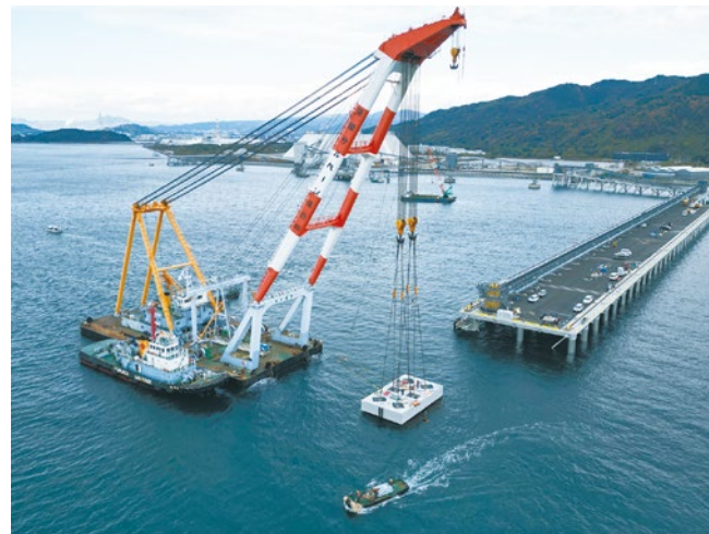
プレキャスト上部工据付状況
