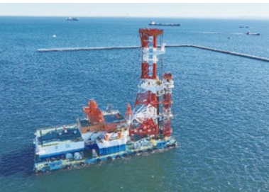
▶令和6年度 横浜港新本牧地区中仕切堤他海上地盤改良工事 発注者 国土交通省関東地方整備局
