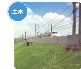
▲山陽新幹線西厚狭地区工事
