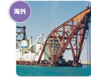
▲スエズ運河浚渫工事 (エジプト)
