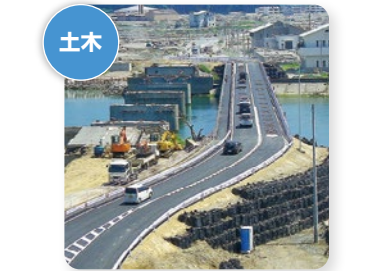
▲気仙大橋仮橋工事
