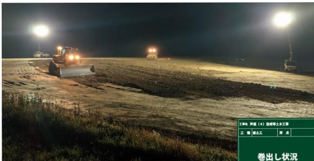
ICT施工による土砂敷き均し状況
