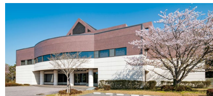
大学校舎改修事例
