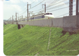
▲山陽新幹線西厚狭地区工事
