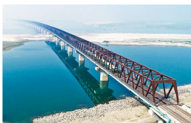
▶ ジャムナ 鉄道橋建設工事 東工区 パッケージWD1※ 発注者 バングラデシュ人民共和国鉄道省 ※ 従前より工事名が変更されました。 旧工事名:バンガバンドゥ シェイク ムジブ鉄道橋 建設工事 東工区 パッケージ WD1
