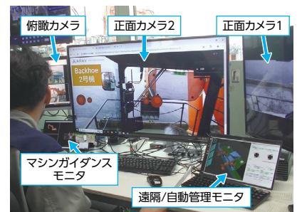
遠隔操縦/自動運転システムによる施工状況
