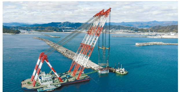
高知港の防波堤築造工事
