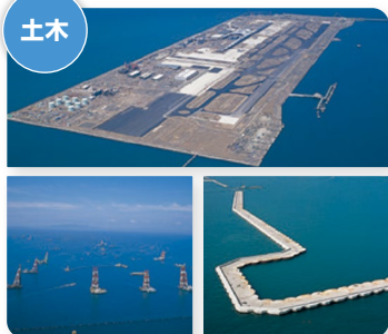
▲関西国際空港第1期工事
