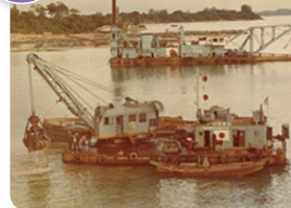
▲ジュロン地区浚渫工事(シンガポール)
