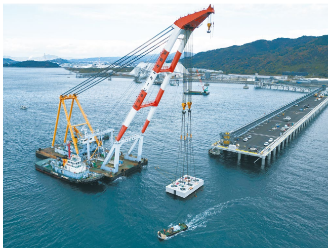
プレキャスト上部工据付状況
