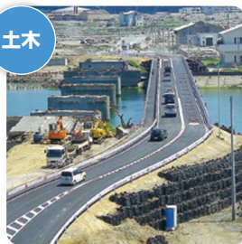
▲気仙大橋仮橋工事
