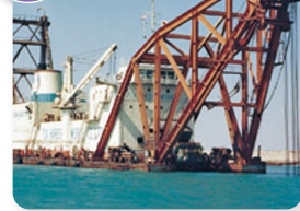
▲スエズ運河浚渫工事(エジプト)
