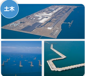
▲関西国際空港第1期工事
