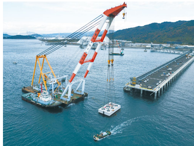
プレキャスト上部工据付状況
