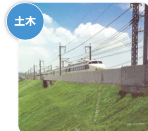
▲山陽新幹線西厚狭地区工事
