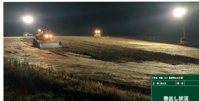
ICT施工による土砂敷き均し状況
