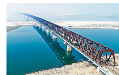
▶ジャムナ 鉄道橋建設工事 東工区 パッケージWD1* 発注者 バングラデシュ人民共和国鉄道省 ※ 従前より工事名が変更されました。 旧工事名:バングバンドゥシェイクムジブ鉄道橋建設工事 東工区 パッケージ WD1
