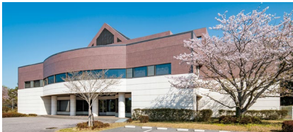
大学校舎改修事例
