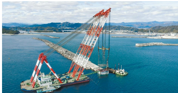
高知港の防波堤築造工事
