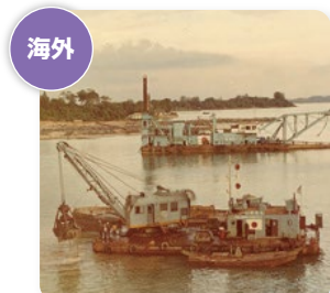
▲ジュロン地区浚渫工事 (シンガポール)
