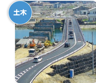
▲気仙大橋仮橋工事
