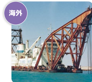
▲スエズ運河浚渫工事 (エジプト)
