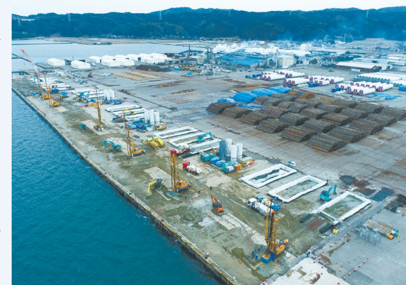
七尾港大田岸壁の災害復旧工事の様子
