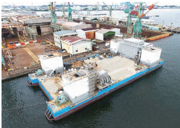
建造状況 2021年8月
