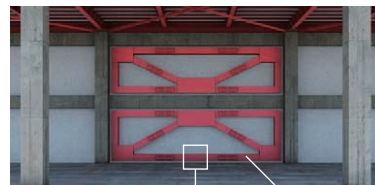
鉄骨枠付きブレース
