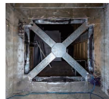
断熱材の設置状況
