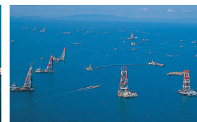
地盤改良工事
