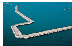
根入れ式鋼板セル工法
