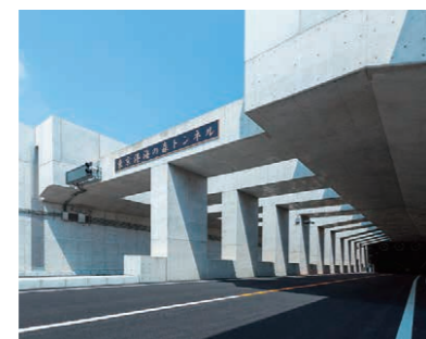
工事名 東京港海の森トンネル 建設事業 発注者 国土交通省関東地方整備局 工事場所 東京都江東区
