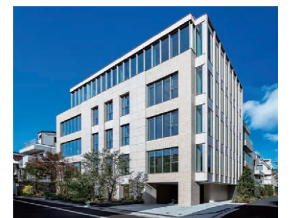
工事名 (仮称)目黒区鷹番3丁目計画新築工事 発注者 株式会社 モリモト 工事場所 東京都目黒区
