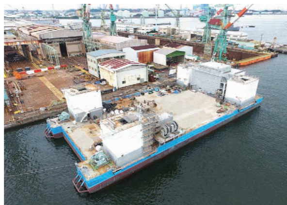
建造状況 2021年8月
