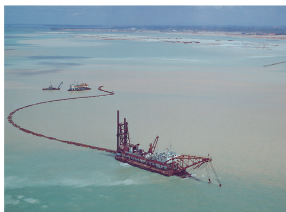
シンガポール/チャンギー空港埋立工事
