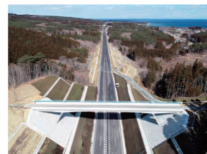
工事名 国道45号 坂ノ下地区道路改良工事 発注者 国土交通省東北地方整備局 工事場所 岩手県九戸郡洋野町
