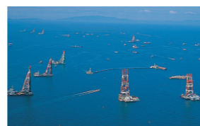
地盤改良工事
