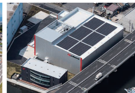
工事名 横浜みらいHRD・横浜みらいサテライト 発注者 横浜冷凍株式会社 工事場所 神奈川県横浜市
