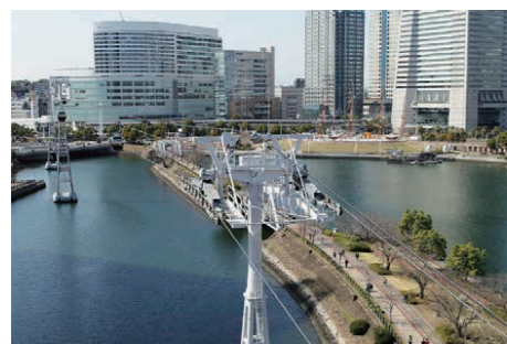
工事名 横浜ロープウェイ建設工事の内、海上支柱基礎工事 発注者 泉陽興業株式会社 工事場所 神奈川県横浜市
