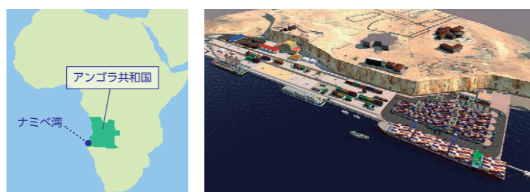
■アンゴラ共和国 ナミベ湾の包括開発(建設)の工事を開始 新型コロナウイルス感染症拡大の影響で着工が遅れていたサコマル鉄鉱石輸出棧橋の新設工事とコンテナターミナル追加建設工事を2021年2月に開始しました。当社は棧橋、岸壁等の港湾施設の建設、コンテナターミナルの整備、港湾管理棟等の施設建設、浚渫の設計・施工を担当。内戦で停止していた鉄鉱石の輸出再開などを支援し、同国の経済活性化に貢献します。
