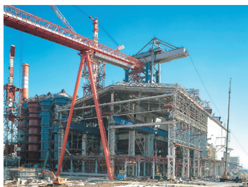
日本鋼管株式会社扇島高炉上屋建設工事
