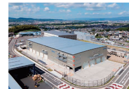
工事名 (仮称)近畿北部LC新築工事 発注者 日本酒類販売株式会社 工事場所 京都府城陽市
