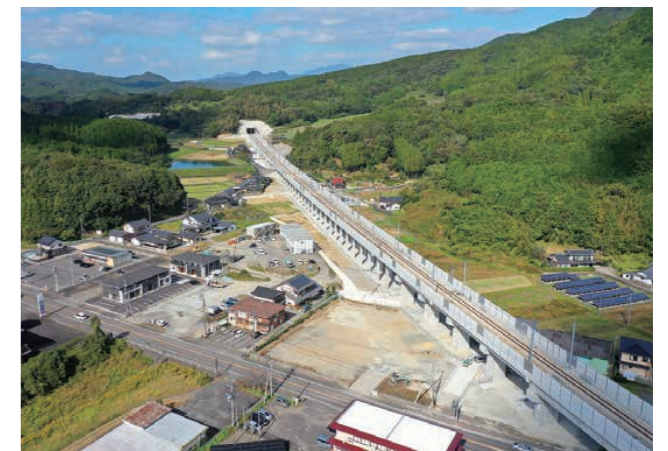
佐賀県武雄市 九州新幹線(西九州)、大草野トンネル外1箇所他工事
