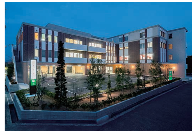
兵庫県三田市 医療法人社団青山会（仮称）複合施設まんかい新築工事
