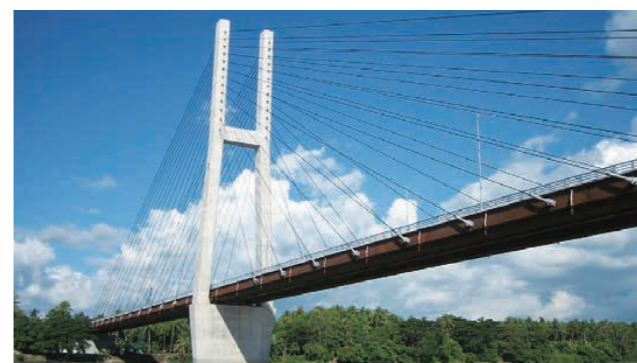
フィリピン 第二マグサイサイ橋・バイパス道路建設事業
