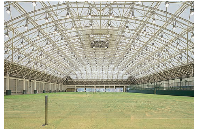
和歌山県和歌山市（仮称）つつじが丘テニスコート場建設工事
