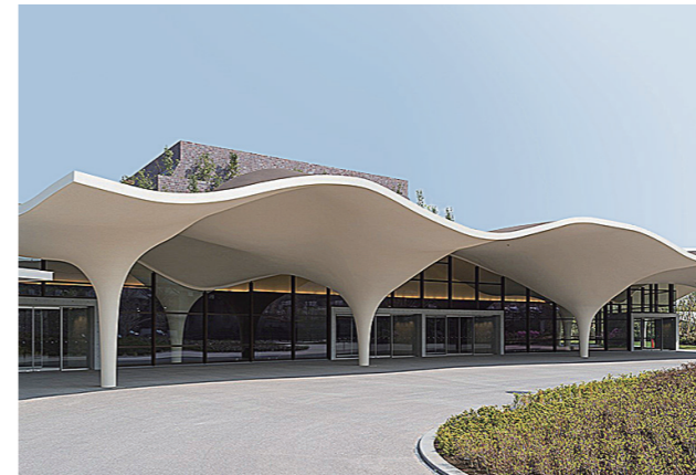
埼玉県川口市（仮称）川口市火葬施設建設工事
