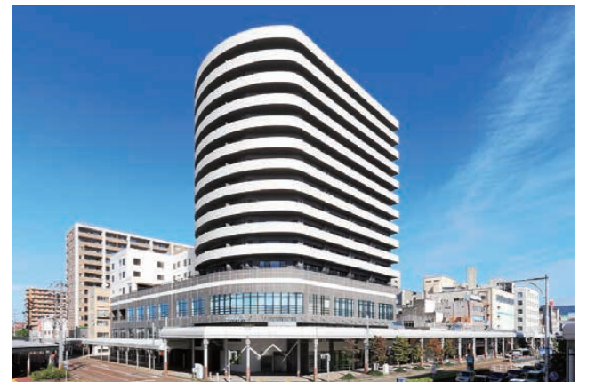
新潟県長岡市 大手通表町西地区第一種市街地再開発事業における建設工事
