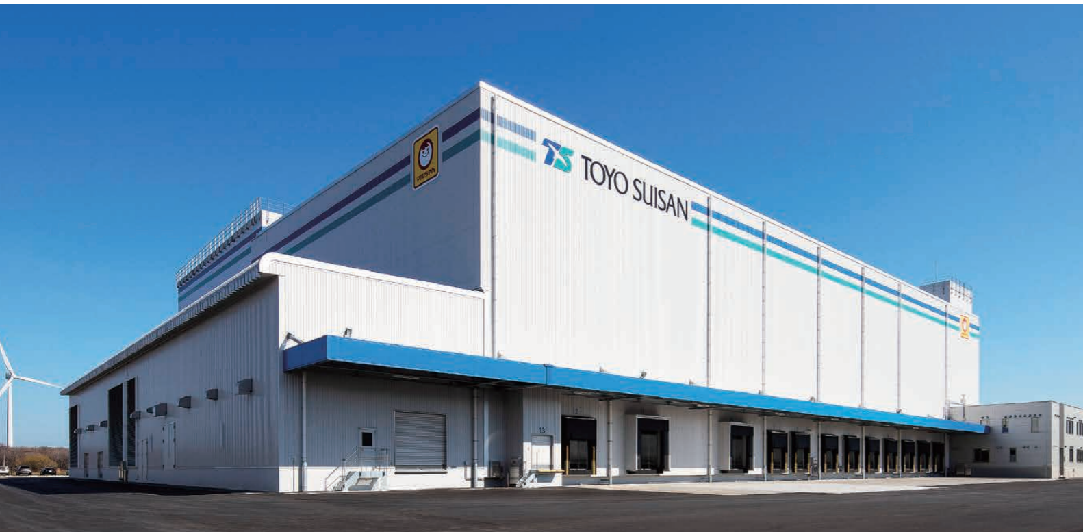
北海道小樽市（仮称）東洋水産株式会社 石狩物流センター新築工事
