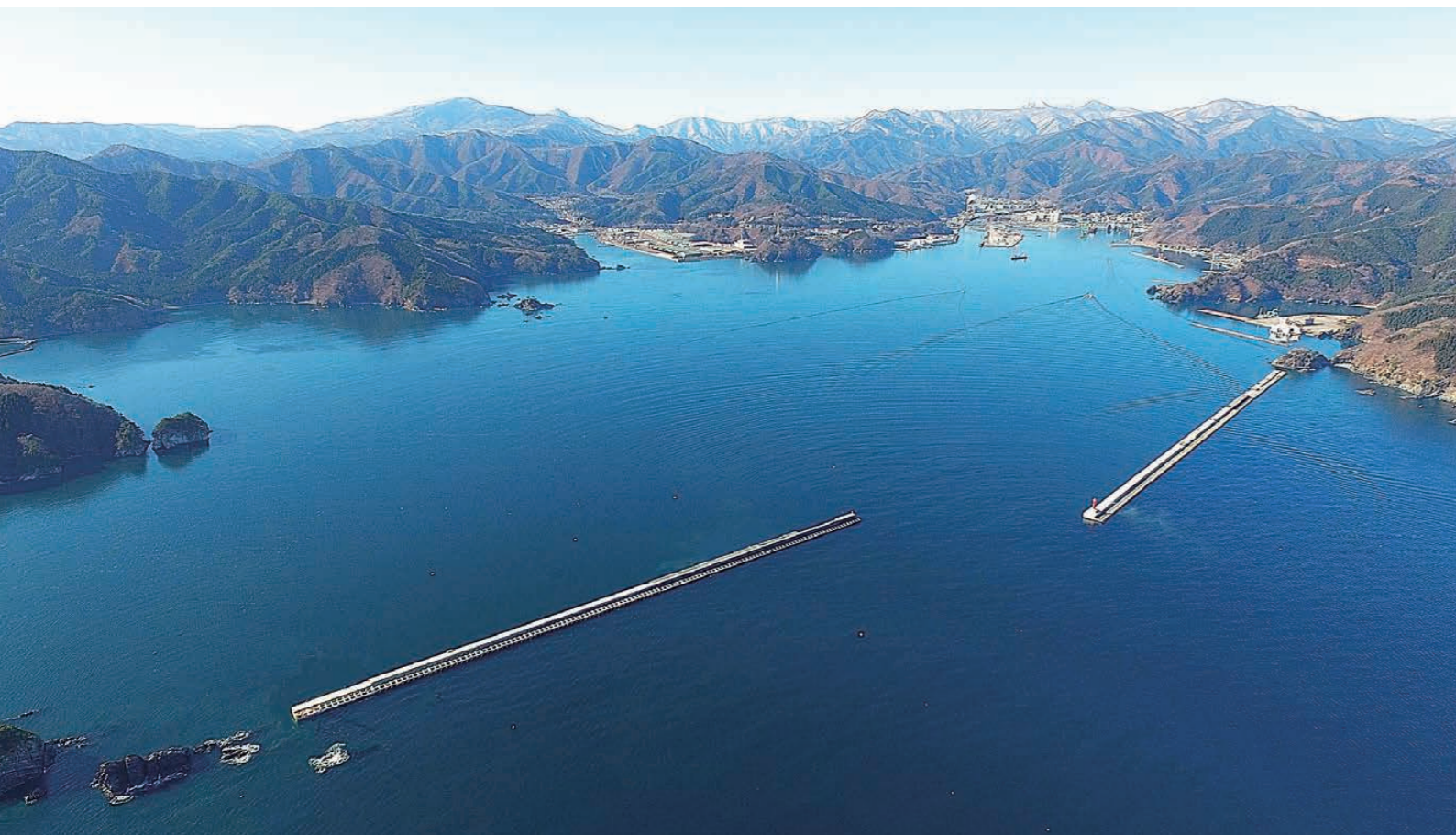
岩手県釜石市 釜石港湾口地区湾口防波堤(災害復旧)(北堤)築造工事
