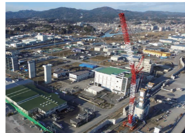
宮城県気仙沼市 国道45号気仙沼横断橋松崎地区下部工事
