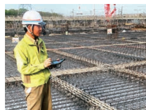
ICTを活用した現場管理
