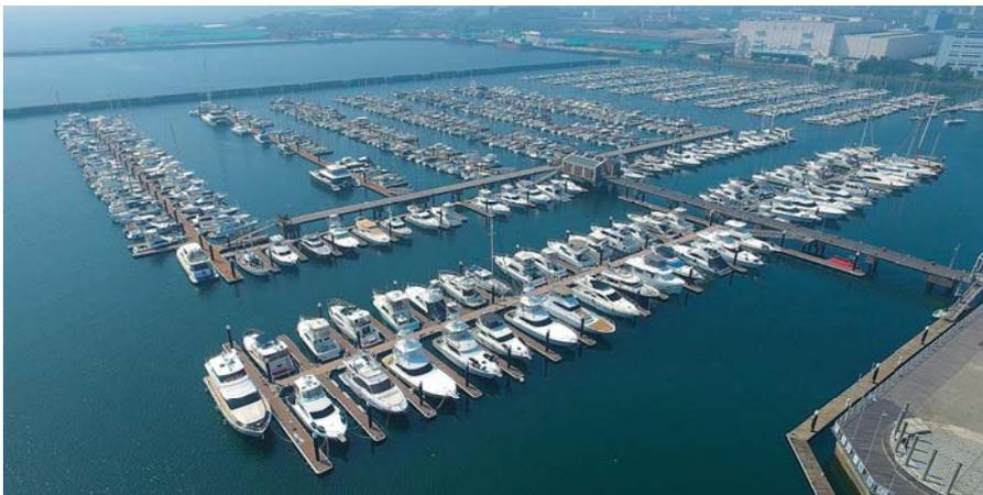
神奈川県横浜市では、「平成29年度センター地区大型艇係留棧橋改修他工事」が完成しました。建造から20年以上経過し老朽化した木製の浮棧橋を解体・撤去し、天然木材に近い質感をもつ人工木材と海洋環境において耐久性の高いアルミフレームを用いた浮棧橋を新設した工事です。細部の寸法にこだわった係留設備、近年増加傾向にある大型艇に対応した棧橋レイアウトなど、日本最大級のマリーナにふさわしい質・外観を誇る施設となっています。
