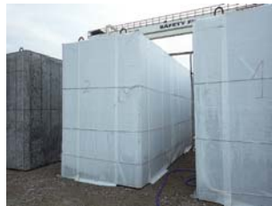
モイスマットによる養生状況
