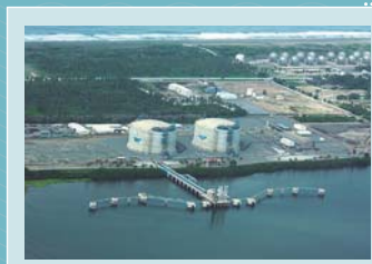
マンザネーショ LNG 受入棧橋建設工事 メキシコ (2011年)
