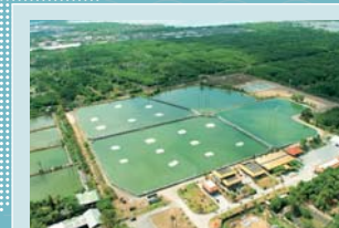
デンバサール下水施設整備工事 インドネシア (2013年)
