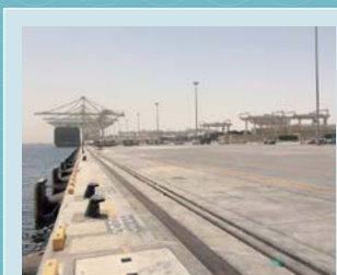
ジュベル・アリ コンテナターミナル建設工事 アラブ首長国連邦 (2014年)
