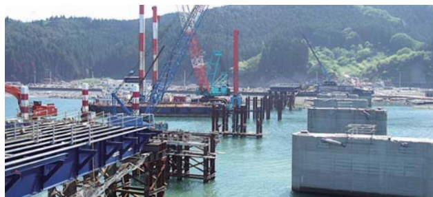
作業船を使用した仮設橋工事（2011年6月）
