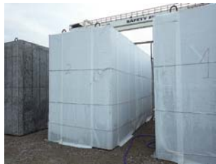
モイスマットによる養生状況
