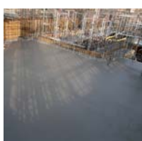
コンクリート打設後の様子
