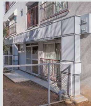
KG 構法施工状況
