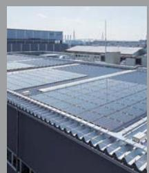
省エネ設備 屋上にパネルを設置して太陽光発電を実施、毎日の発電量をエントランスの表示モニターで確認、自然光を積極的に取り入れて消費電力を削減など、数多くの省エネ技術が導入されています
