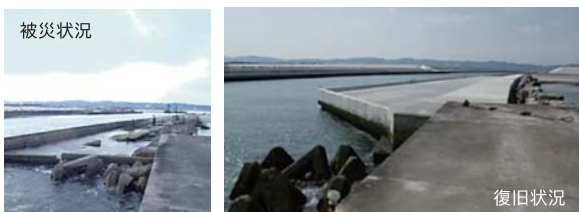
被災状況 復旧状況 宮城県亘町の荒浜漁港において北導流堤(L=480m)を復旧するもので、当社は南導流堤災害復旧工事も同時期に施工し、2015年3月までに完了しました。
