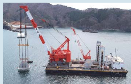
起重機船による逆T型ブロックの沈設据付状況
