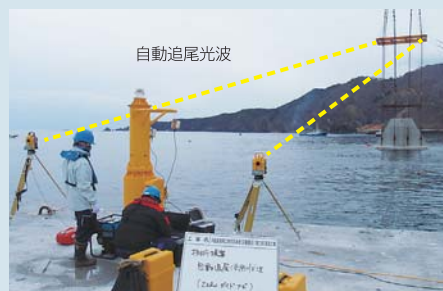
自動追尾光波を利用した吊棒誘導システム
