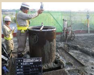
下杭座標確認（トータルステーション）
