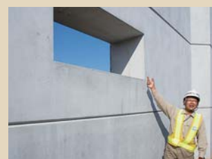
地元関係者の要望により設けられた監視窓
