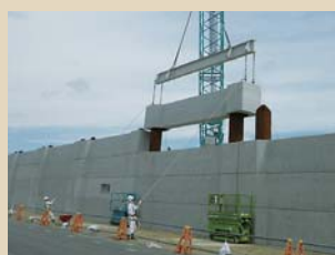
壁ブロック据付状況
