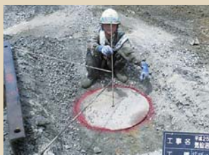
杭芯マーキング
