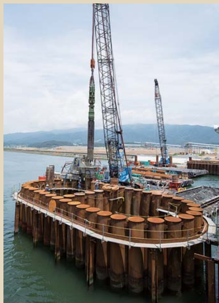
鋼管矢板中堀圧入状況 クレーンで吊り揚げたカプセルホウにより中堀し、既に打設した鋼管矢板を反力としてパイラにより圧入を行う
