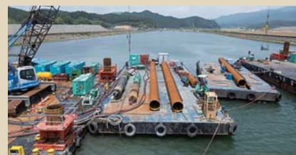
揚陸ヤードから資材台船で運搬されてきた鋼管矢板
