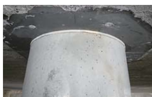
タフリードPJ工法による接合部の補強状況
