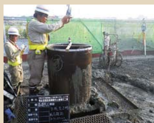
下杭座標確認（トータルステーション）
