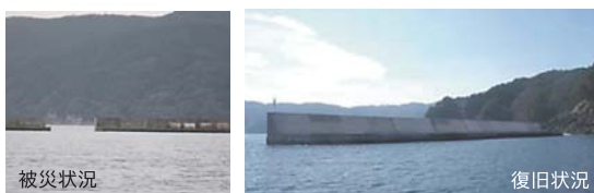
被災状況 復旧状況 岩手県釜石市の唐丹漁港において西防波堤L=120mの復旧を行うもので、ケーソン製作を含め、2015年3月に完了しました。
