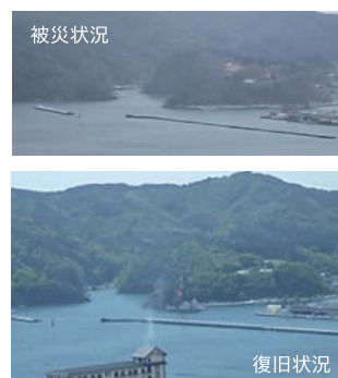
被災状況 復旧状況 大船渡漁港の細浦地区において、西第1防波堤(L=361m)及び東第1防波堤(L=194m)の復旧を行うもので、2014年8月に完了しました。
