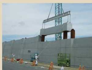
壁ブロック据付状況
