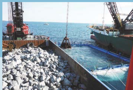
汚濁防止枠の中に投入される基礎捨石
