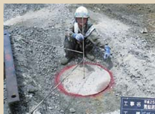
杭芯マーキング
