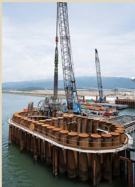
鋼管矢板中堀圧入状況 クレーンで吊り揚げたカプセルホウにより中堀し、既に打設した鋼管矢板を反力としてパイラにより圧入を行う
