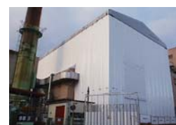
焼却施設の密閉状況
