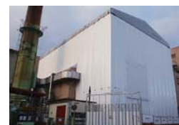
焼却施設の密閉状況
