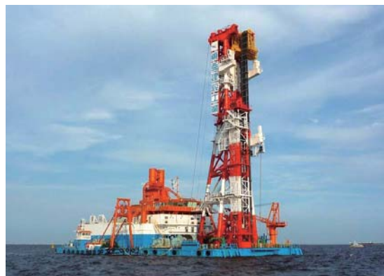
海面処分場地盤改良工事に就役中の「黄鶴」
