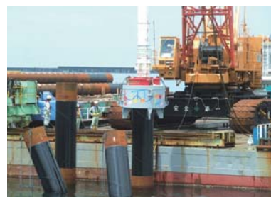
低減装置の打設実験状況(直江津)
