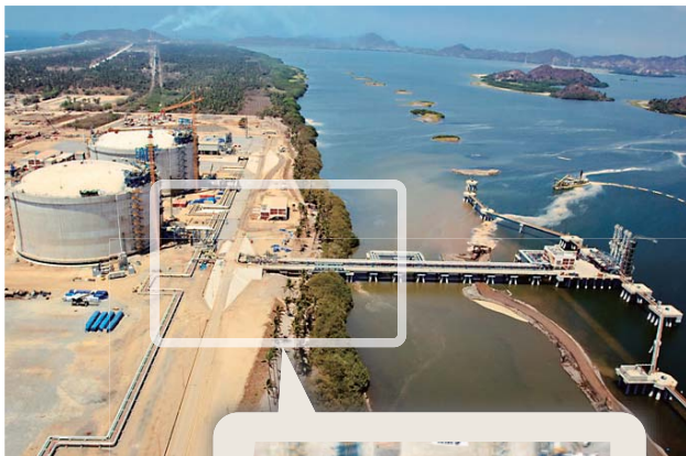
LNG受入棧橋全景
