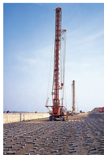
スパイラルドレーン打設状況
