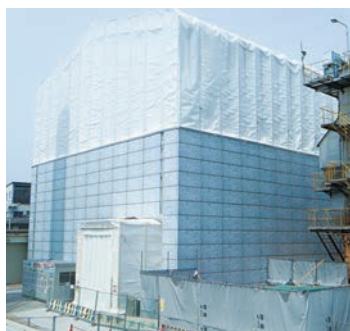
「ビームテント養生」による密閉化
