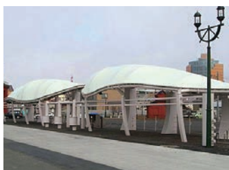
通常時の利用にも配慮した設置事例（釧路港） ／高潮・津波バリアー研究会HPより
