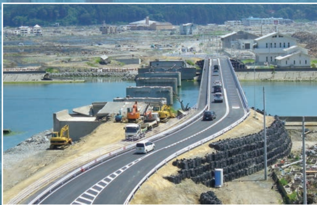
開通後の気仙大橋仮橋
