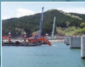
バックホウ台船で川底を浚渫
