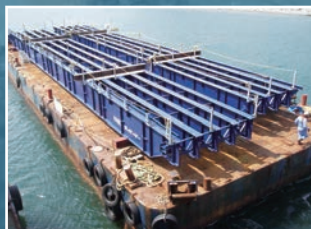
1000t積み鋼台船で桁を運搬
