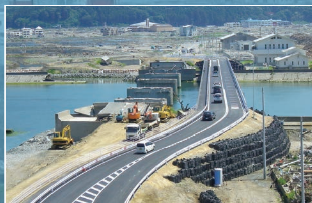
開通後の気仙大橋仮橋
