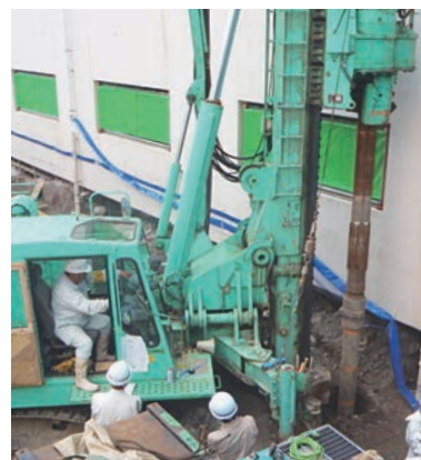
回転圧入鋼管杭施工の様子
