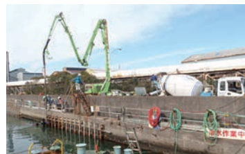
被覆コンクリートの施工状況
