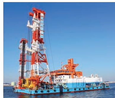
環境配慮型の深層混合処理船「黄鶴」
