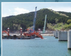
バックホウ台船で川底を浚渫
