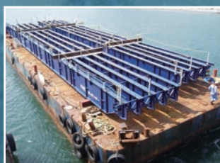
1000t積み鋼台船で桁を運搬
