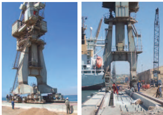
施工状況 / 既設走行クレーン移動
