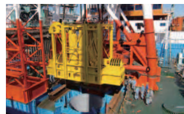
セメント系硬化剤を海底地盤に注入するための処理機の搭載
