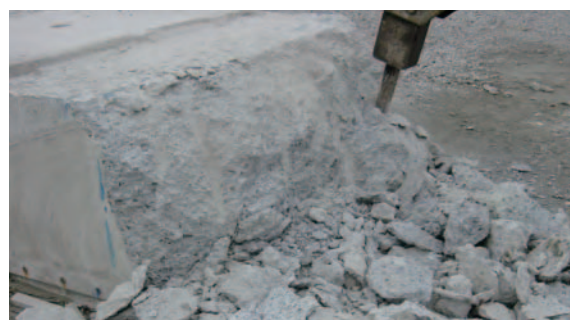
老朽化が進み撤去された海洋コンクリート構造物を小割りにする
