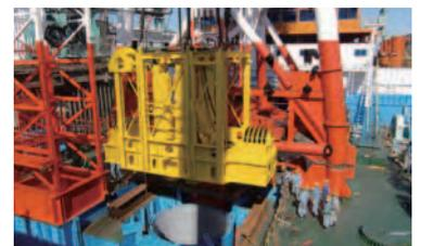
セメント系硬化剤を海底地盤に注入するための処理機の搭載
