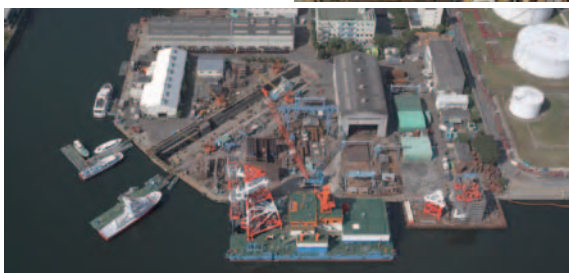
東亜鉄工全景（神奈川県横浜市鶴見区安善） 乾ドックでは船の建造や修繕が行なわれている。
