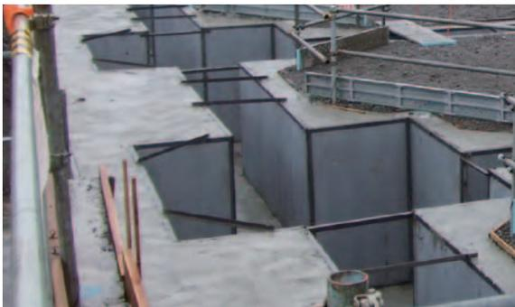
型枠設置後、周辺の埋め戻しを行ない表面のコンクリート打設まで完了した状態
