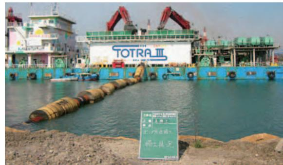
高濃度軟泥空気圧送船による浚渫土運搬
