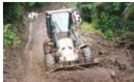
土砂崩れの撤去作業
