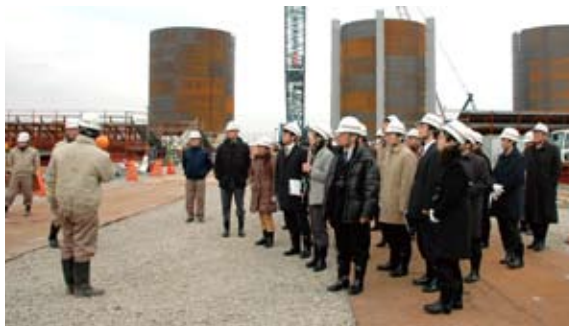
横浜港南本牧ふ頭 銅板セル製作現場にて
