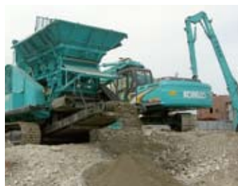
自走式破砕機による 再生砕石リサイクル状況
