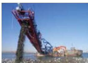
鉄鋼スラグ人工石材埋立状況
