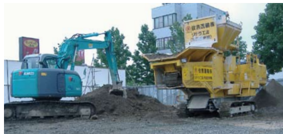
中間残土処理リテラ工法
