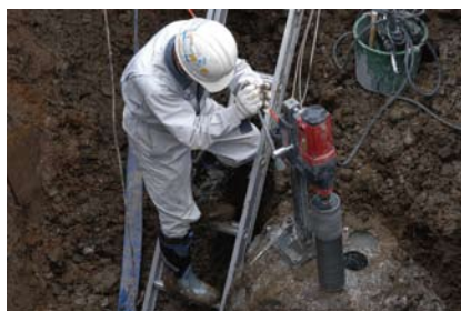
既存杭の調査状況
