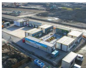
休憩所ハウス全景
