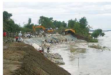
緊急復旧工事状況
