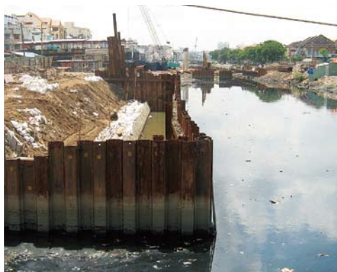
ベンゲ運河護岸改修工事状況
