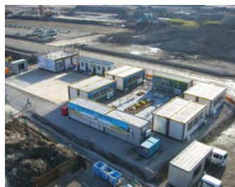
休憩所ハウス全景
