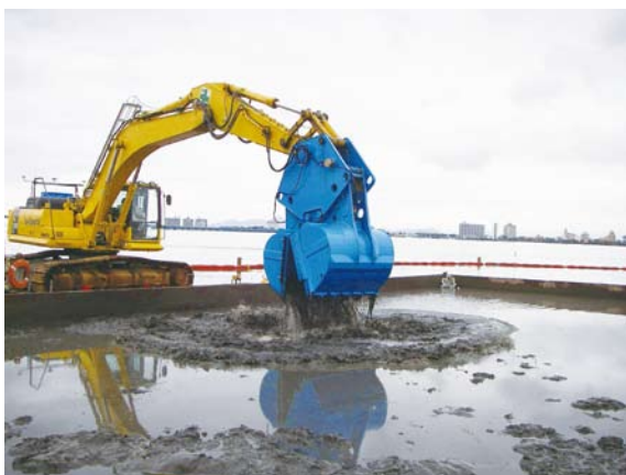
写真1 スーパーグラブバケット（バックホウ型）による浚渫
