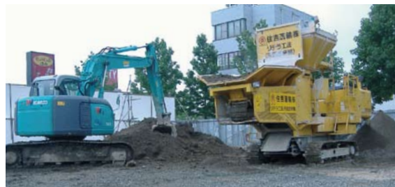
中間残土処理リテラ工法
