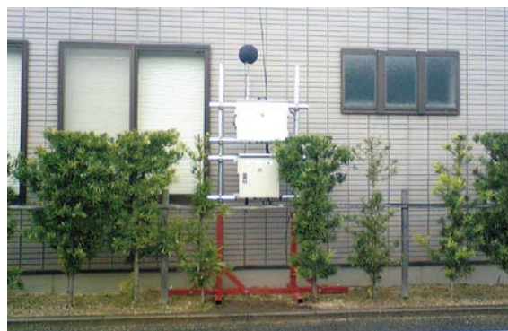
現場周辺の病院前に設置した騒音計と発信器
