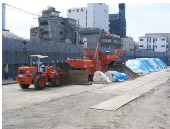
写真3 汚染土壌処理（不溶化処理）
